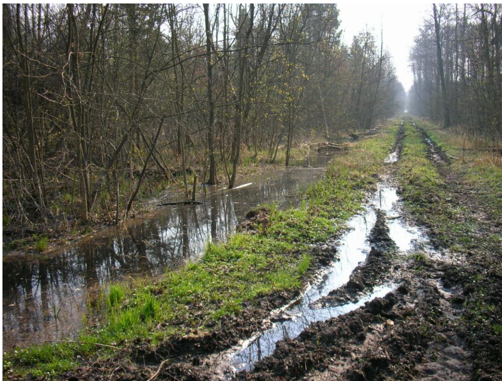
Fot. 11.2. Nieprzejezdny fragment drogi gruntowej w okresie wiosennym. (fot. M. Korzak)
