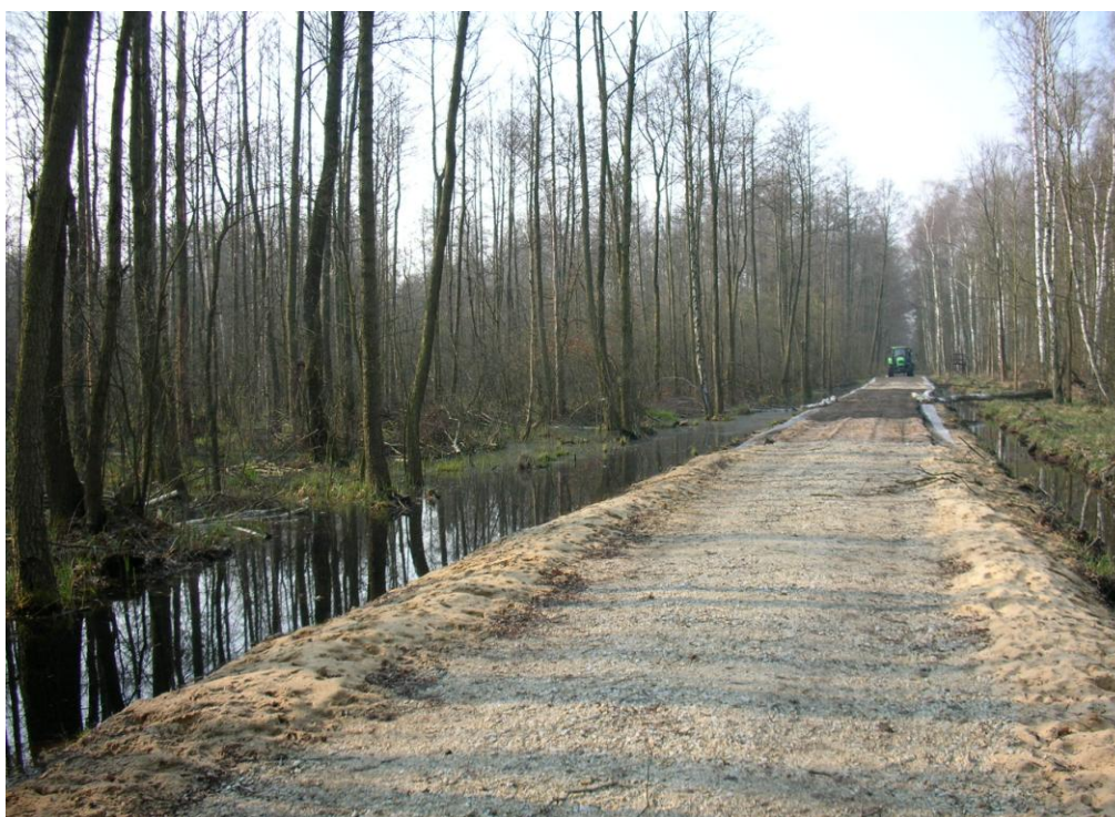
Fot. 11.1. Całkowicie przejezdna droga leśna w okresie wiosennym – nawierzchnia z geosyntetyków. (fot. M. Korżak)
